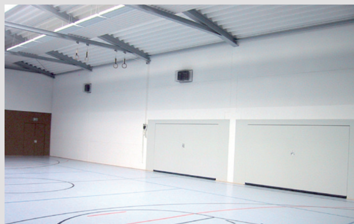
Wykończone wnętrze hali sportowej
